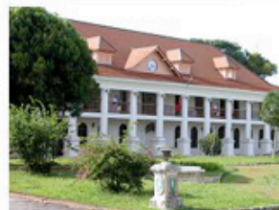
Palais des jésuites devenu préfecture
